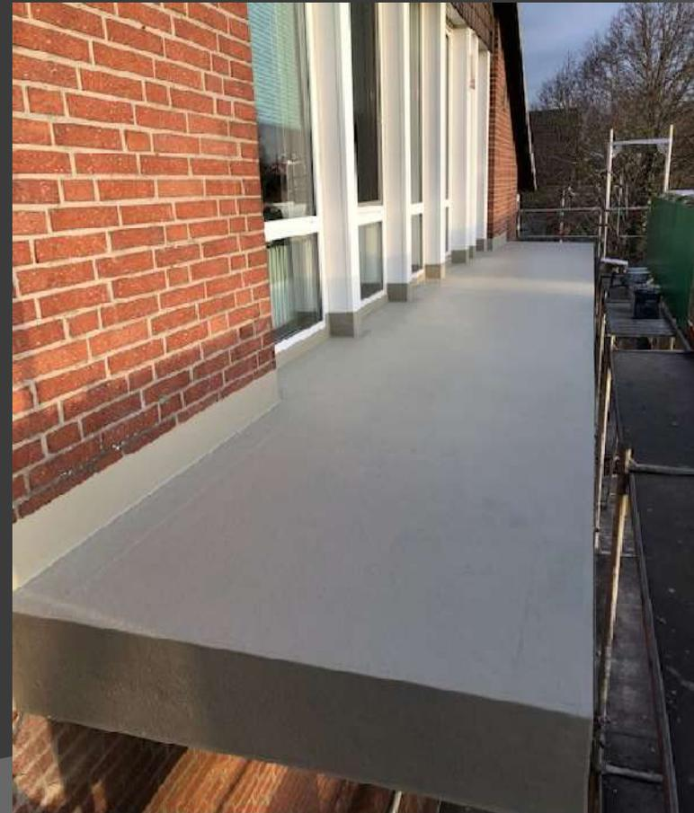
Fläche mit der Ausgleichsmasse Triflex Pro Floor versehen.
