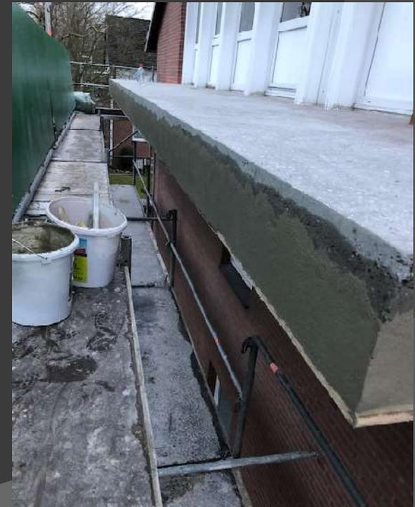
Sauberen Andichtungsanschluss zum Mauerwerk mit der Fräse erstellen.
