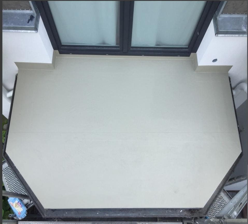
Fläche mit der Ausgleichsmasse Triflex Pro Floor versehen
